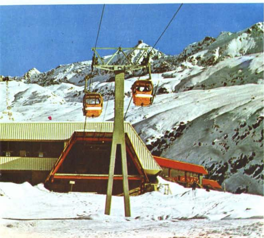
Equipamiento turístico de la montaña. El nuevo telecabinas monogable "Poma" con cabinas de 6 plazas, instalado recientemente en la estación francesa L'Alpe d'Huez. Capacidad: 2.000 viajeros/hora. Foto J. Hirigoyen.
