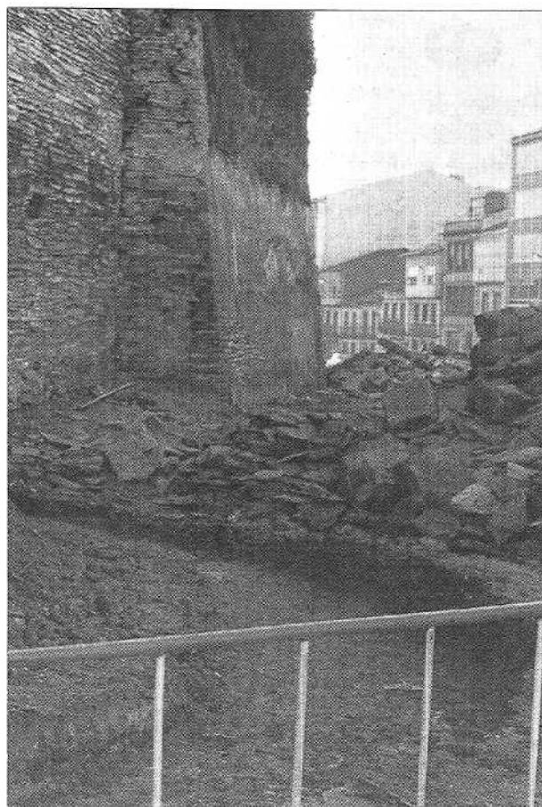
Zanja de cimentación de un nuevo cubo construido en 1974. (Lado oeste de la puerta de San Fernando.) No existen restos de cemento anterior.
