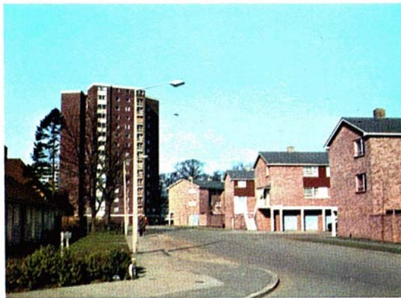
Hatfield, falta de coherencia entre los diferentes tipos de edificios.
