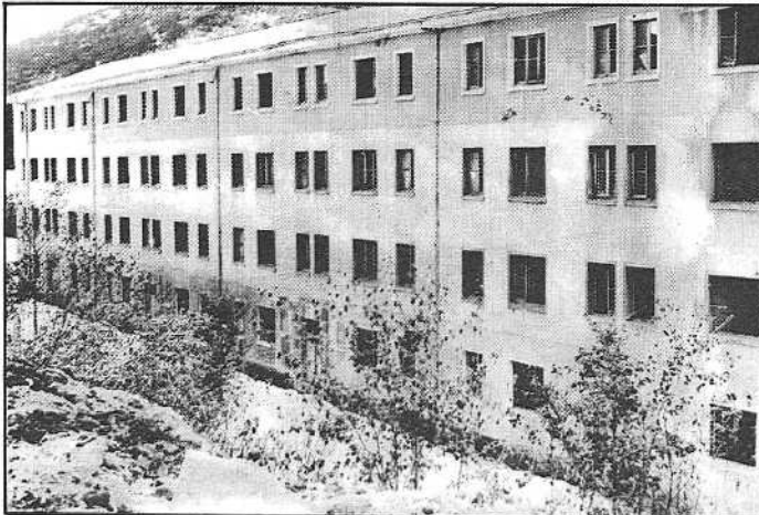
Viviendas abandonadas entre Tremor de Arriba y Almagariños.
