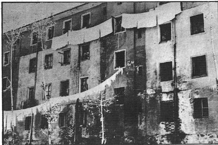
Viviendas de empresa en Tremor de Arriba.
