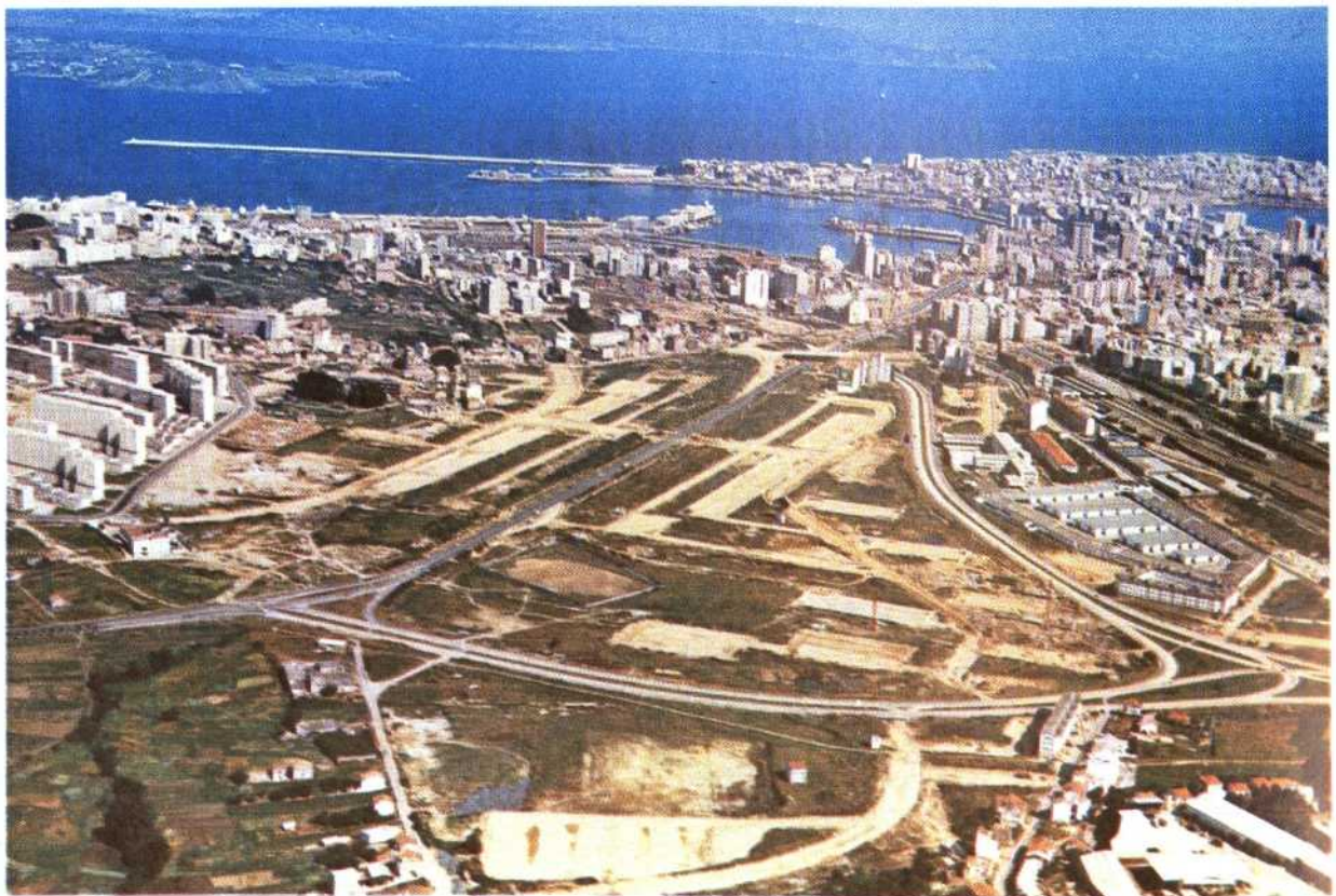
Polígono Residencial en La Coruña, en fase de urbaniza- ción.
