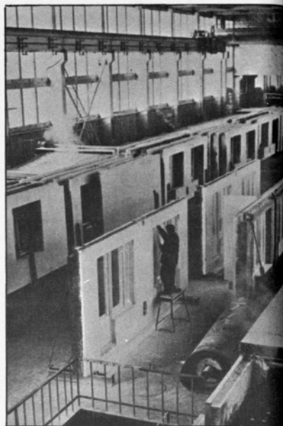
La prefabricación de elementos, como salida al problema de la vivienda.
