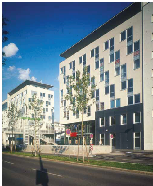
FIG. 10/ Calle Anton Baumgartner, edificio de oficinas.
