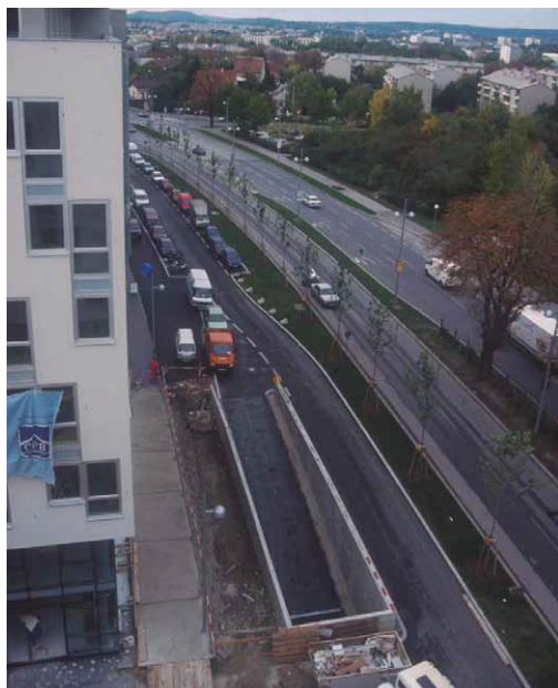
FIG. 12/ Accesos al aparcamiento subterráneo en el carril lateral.
