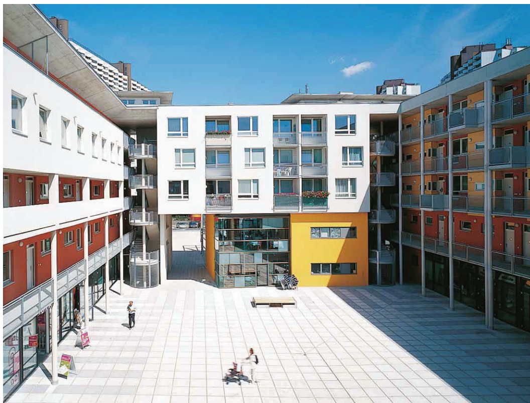
Fig. 15/ Patio interior abierto de manzana en el tramo derecho, alojamiento intergeneracional.
