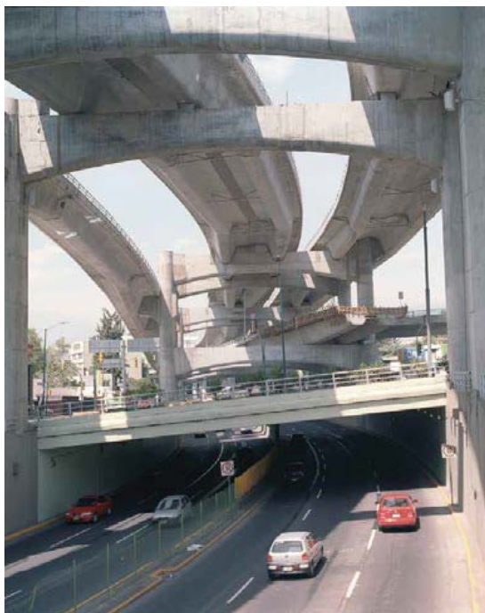
FIG. 9/ México D.F. Periférico elevado.
