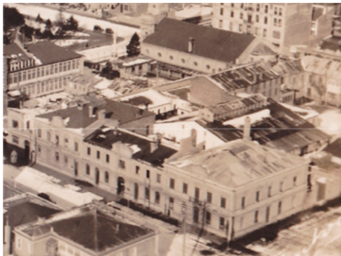
FIG. 3 / Fotografía Histórica de la Ex – Cárcel de Punta Arenas y Edificios de Gendarmería y Casa del Juez
