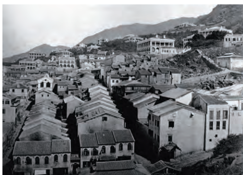
Fig. 3/ Tong Lau construidos en Hong Kong en el barrio de Tai Pin Shang, 1887.
