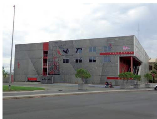
FIG. 3/ La antigua base del equipo de regatas «Luna Rossa» en la zona portuaria de la Marina Real Juan Carlos I de Valencia, proyectado por Renzo Piano en 2007, se demolió en 2016.
