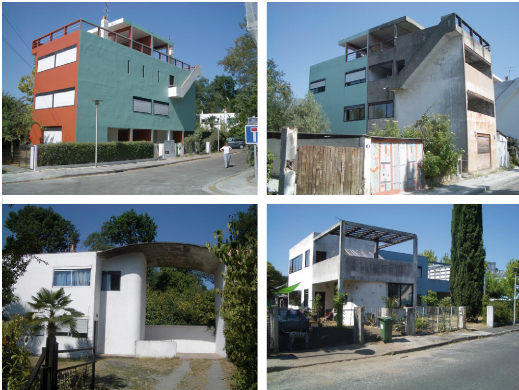
FIG. 8/ Estado de conservación de diversos edificios de Cité Frugès en la periferia de Burdeos en 2011.
