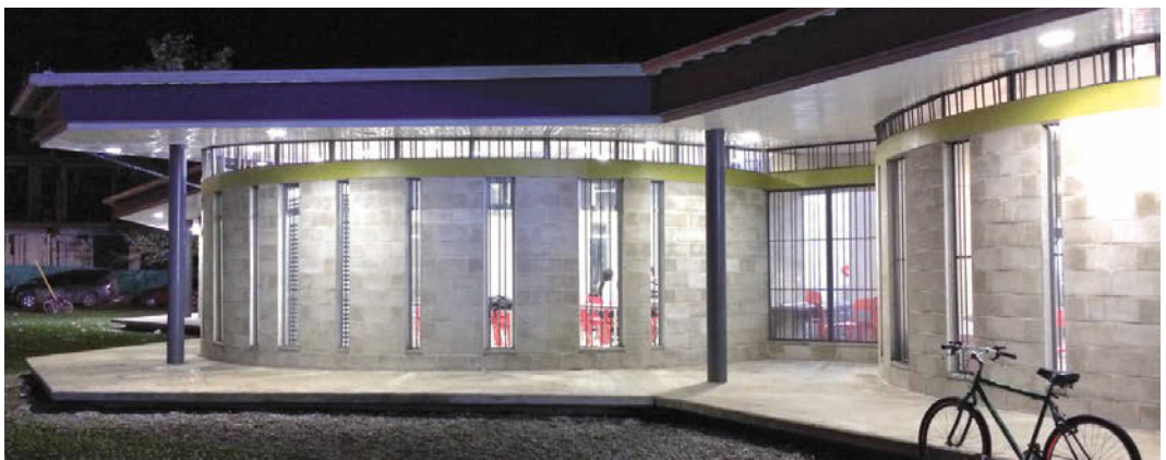
FIG. 1/ Vista del espacio exterior.
