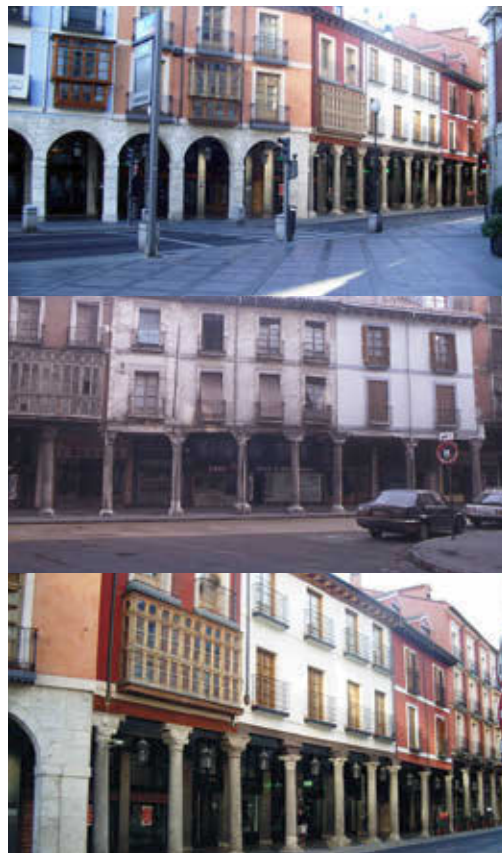
FIG. 5/ Transformaciones en la calle Cebadería.
