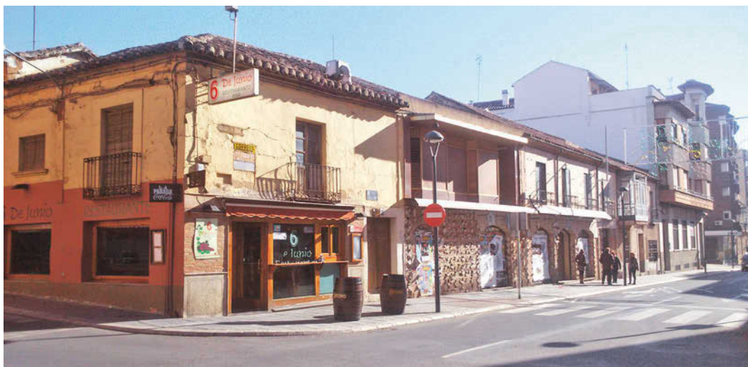
FIG. 3/ Edificación a renovar en la UA 31.5. La actuación libera la esquina de la foto (calles Seis de Junio y Torrecilla) como plaza o zona verde, considerando deficiente la edificación actual; y permite edificar cuatro plantas con frente de 10 metros tapando la medianería actual que aparece al fondo de la foto. El resto del incremento de edificabilidad se transfiere a otra parcela al norte de éstas
