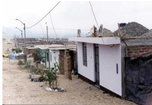
FIG. 4/ Las familias ocupan sus parcelas de forma precaria dando comienzo al proceso de mejora paulatina en función del acceso a los recursos económicos, pero con la seguridad de un título de propiedad. Con el paso del tiempo las viviendas precarias de la primera etapa van siendo sustituidas por viviendas «sólidas» y el municipio comienza a introducir las redes urbanas (alumbrado, saneamiento y abastecimiento de agua, principalmente)
