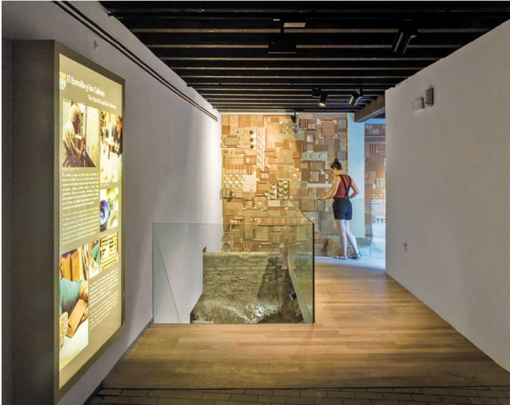
subestructura de acero galvanizado a modo de gran estantería sirve de apoyo para el apilamiento aparentemente desordenado de sencillas piezas huecas de terracota esmaltada de cuatro tamaños diferentes. Esta acción permite la protección solar en función de la orientación, provocar las diferentes miradas hacia el conjunto alfarero y configurar la imagen de una arquitectura nueva a partir de la materia con la que se ha construido este lugar: la Cerámica.
