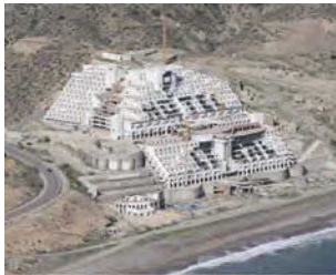
Hotel Algarrobo. Almería. Fuente: laotraandalucia.org
