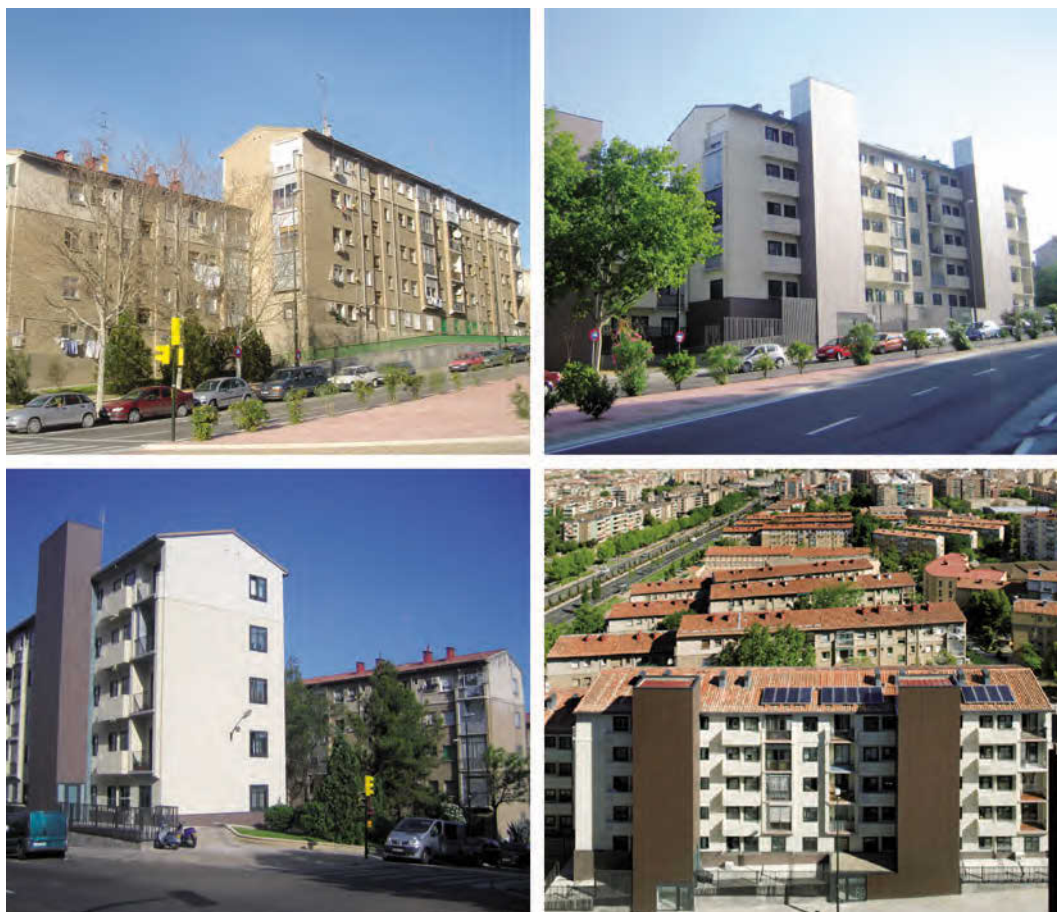
FIG. 10/ Grupo A. Rojas Barrio de Delicias en Zaragoza (año 1960). Imágenes del estado anterior y posterior a la rehabilitación
