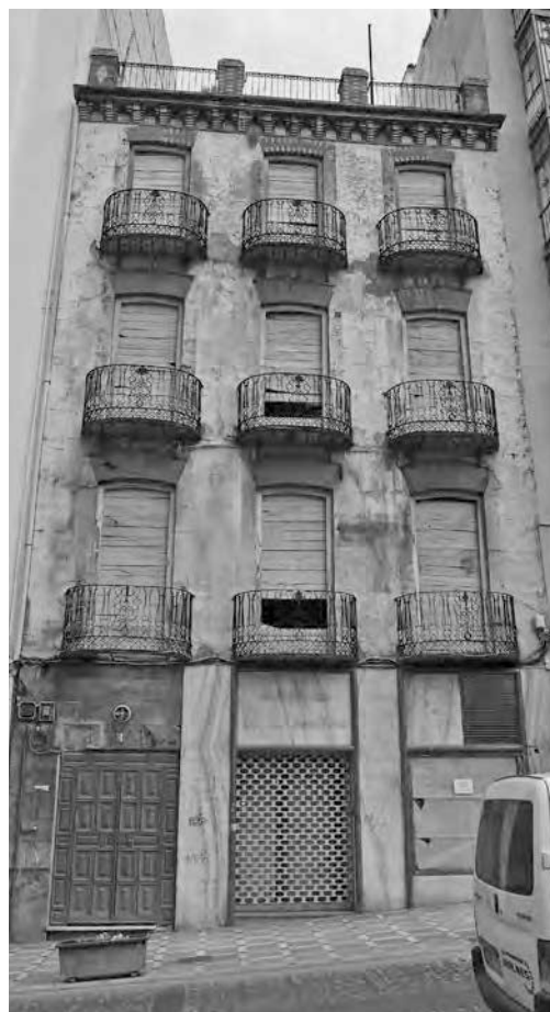
FIG. 4/ Edificio abandonado en el centro de Jaén: ¿Rehabilitación o Renovación?
