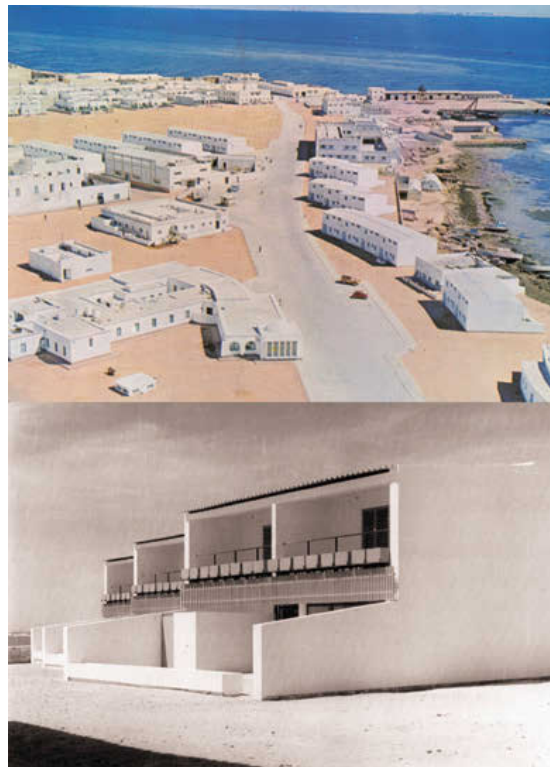
FIG. 14/ Vista de la intervención en Dajla y vivienda (1963)
