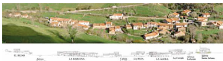
Fig. 10/ Vista y alzado de Lafuente, conjunto lineal construido en torno al camino medieval a partir de la fuente de La Llosa y la iglesia de Santa Juliana
