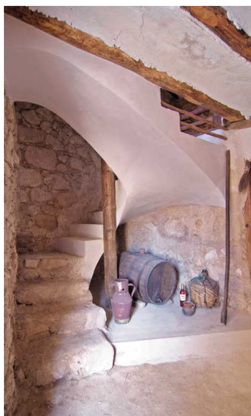
Nueva escalera de acceso a la planta primera en el lagar, que sustituye a la anterior desaparecida.
