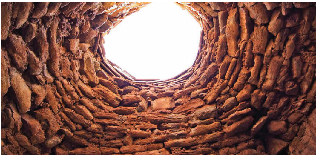
Interior de la cúpula falsa de la tejera de Sesga, una vez restaurada.
