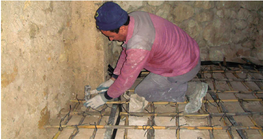
Ejemplo de la aplicación de la capa de compresión de yeso armada con un mallazo de cañizo en el forjado segundo del lagar.
