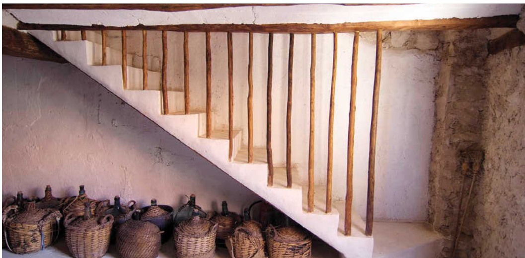
Vista interior de la primera planta de la bodega-lagar.
