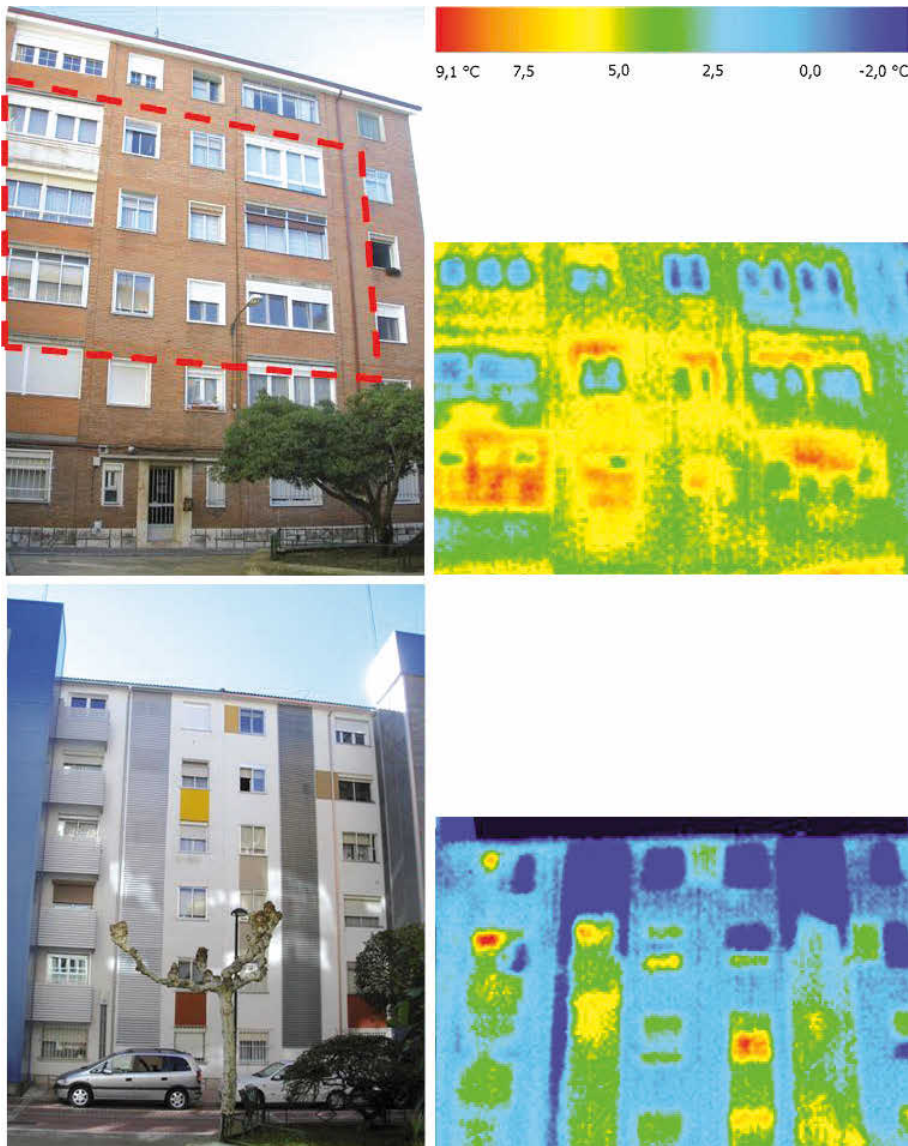
FIG. 3/ Fachadas de los edificios, antes y después de la rehabilitación, imágenes tomadas con cámara termográfica
