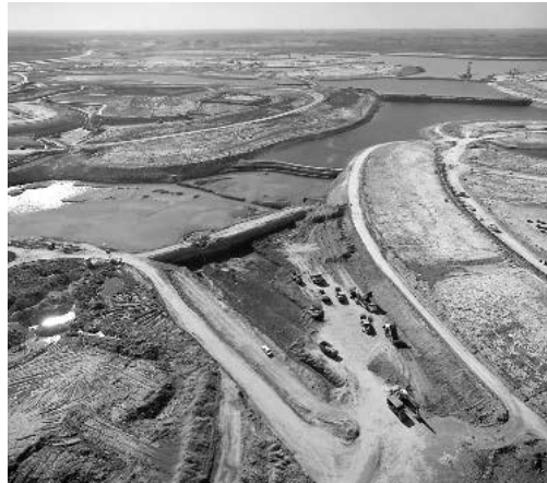
FIG. 3/ Movimiento de suelos y construcción del lago central de Nordelta
