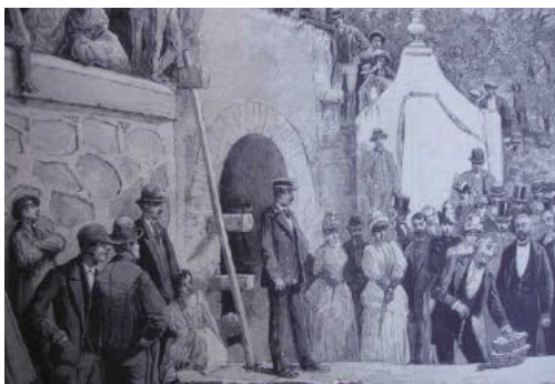
Fig. 2/ Colocación de la primera piedra del manantial de Llantonos para el abastecimiento de agua de Oviedo
