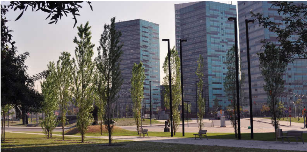
Imagen actual de la plaza Europa con los edificios de viviendas proyectadas por el arquitecto Alonso-Balaguer.
