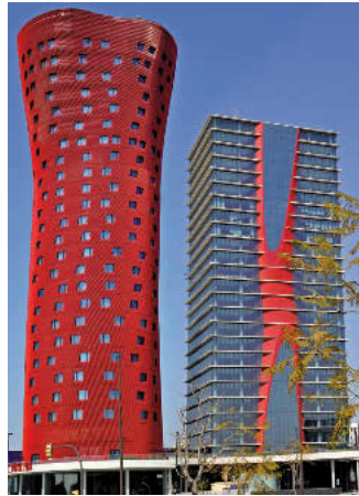
Hotel y edificio de oficinas firmados por Toyo Ito situados en la plaza Europa, icono y puerta de entrada a la nueva instalación ferial.
