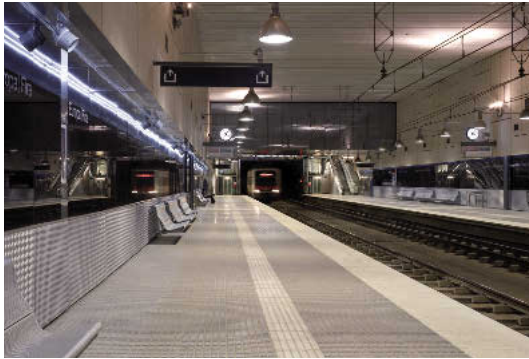
La nueva estación EuropalFira en la Lina 8 construida y financiada por el Consorcio en el nuevo intercambiador de transporte de la plaza Europa.
