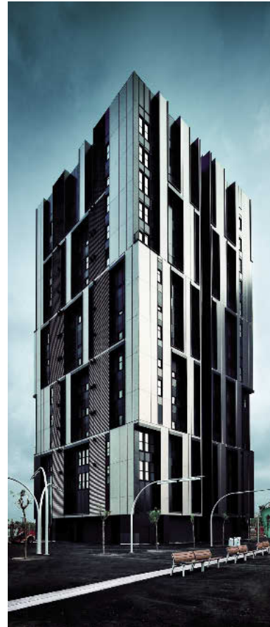
Edificio destinado a vivienda protegida que ha promovidos el Insitut Català del Sòl, obra de Berenguer-Roldan Arquitectos.
