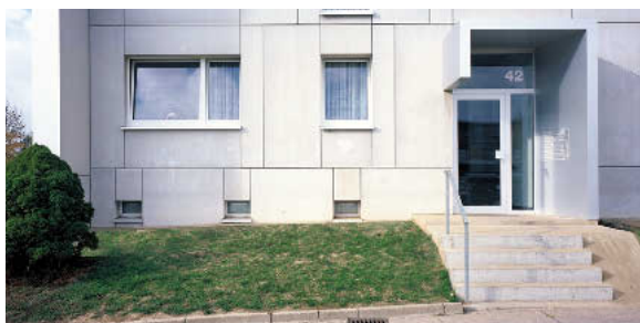
Nuevo portal de acceso a las viviendas tipo Low. © Future Documentation.
