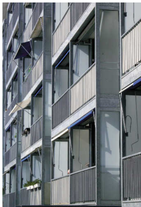
Detalle del cuerpo de terrazas adosado a la fachada original. © Ainhoa Díez.
