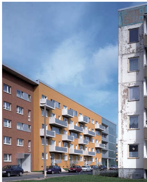
Bloque original y bloque rehabilitado con viviendas tipo Mäander. © Werner Prokschi.
