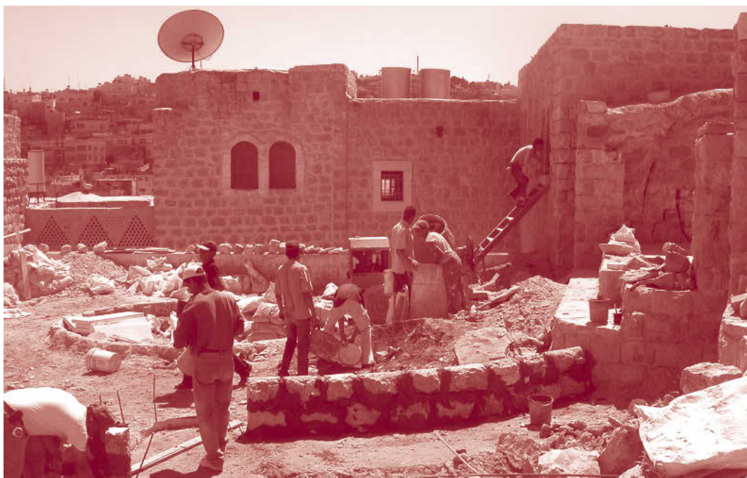
FIG. 2/ Centro Histórico de Hebrón: Trabajos de rehabilitación y edificios rehabilitados
