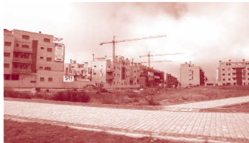
FIG. 4/ Imágenes de la operación inmobiliaria Valdeluz
