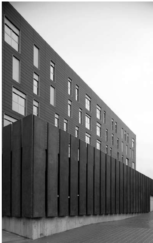
FIG. 4. 45 VPO en Txurdinaga. Vista exterior
