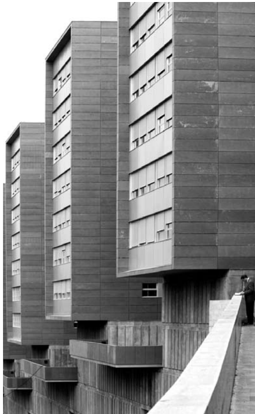
FIG. 2. 70 VPO en la Mina del Morro. Vista desde el sureste
