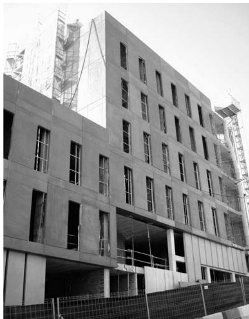
Fig. 6. 55 VPO en Bilbao la Vieja. Fachada bloque I en construcción
