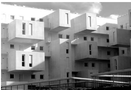
FIG. 17. Vista desde el patio interior de la fachada en la que destacan los volúmenes en voladizo del conjunto “Carabanchel 20”
