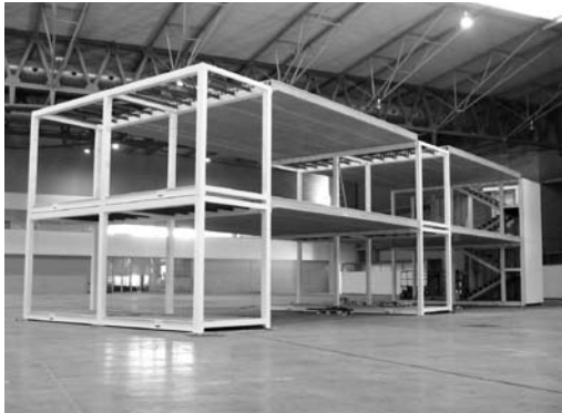
FIG. 11. Sistema estructural a base de elementos prefabricados (pilares, losas aligeradas pretensadas y paneles) montados prácticamente "en seco", que conforman la "Casa Barcelona 2009" en el interior de CONSTRUMAT
