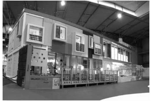
FIG. 12. Prototipo en uso de la "Casa Barcelona 2009" conformada por la concurrencia de una decena de diferentes tipologías de componentes industrializados y de subsistemas constructivos de alto contenido tecnológico, con proyecto del "Equipo de Arquitectura Pich-Aguilera"
