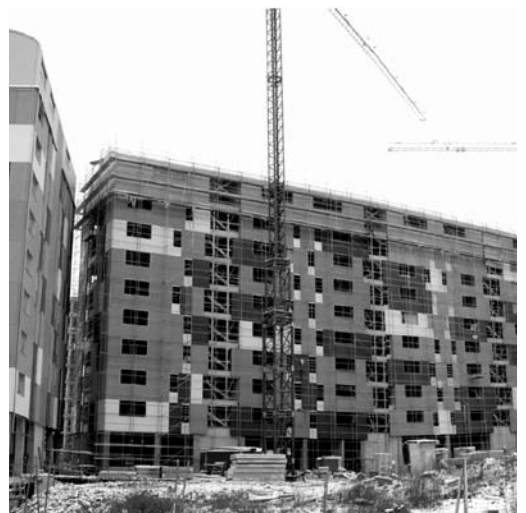
FIG. 7. Etapa de trabajos de acabados en la realización del conjunto de 156 viviendas industrializadas en Vitoria – Gasteiz del Plan Director de Vivienda del Gobierno Vasco, VISESA, a base de bloques de 8 plantas, bajo y ático
