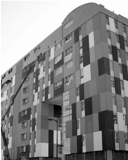
FIG. 8. Detalle de la fachada prácticamente finalizada (2009), conformada por 800 paneles con 12 geometrías diferentes y tres soluciones de fijaciones
