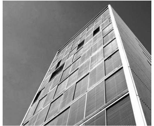
FIG. 16. Detalle de los paneles del testero Norte de la torre de diez plantas a base de paneles metálicos
