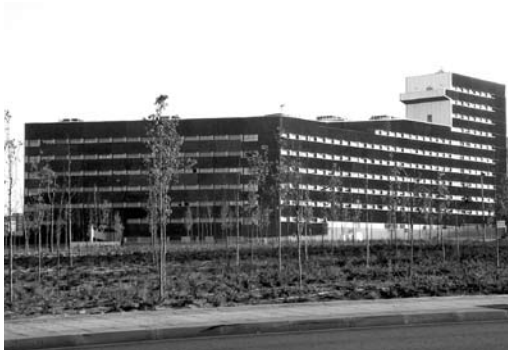
FIG. 15. Vista general de la realización “Sanchinarro 12” promovida por la EMVS en la que destacan las fachadas a base de franjas continuas de elementos prefabricados de hormigón tratado mediante estrias verticales y coloración intensa
