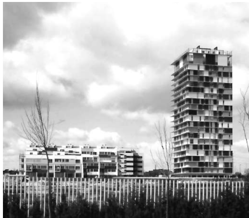
FIG. 14. Ámbitos de actuación. Fachadas. Viviendas Panorama. Junquera y Obal, Isla Chamartín, Madrid
