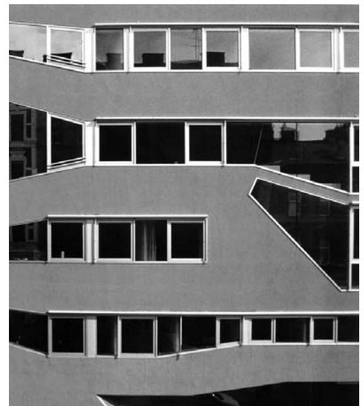
FIG. 7. Acciones tácticas: la fachada revela una sección variada con altura de techo generosa en las habitaciones. Viviendas experimentales en la Missindorfstrasse, Viena. BKK-3
