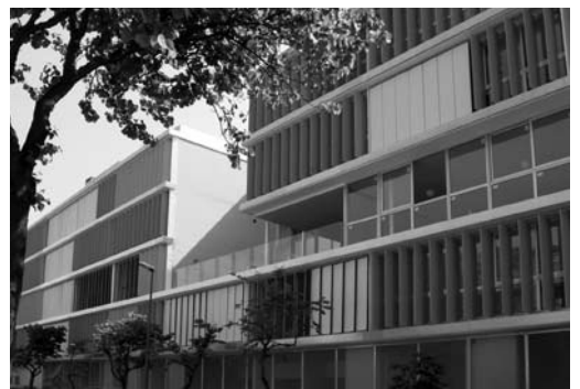
FIG. 10. Ámbitos de actuación: zonas de expansión. Blanca Lleó. Viviendas para jóvenes. Mare de Deu de Port, Barcelona. Edificio de carácter esponjoso
