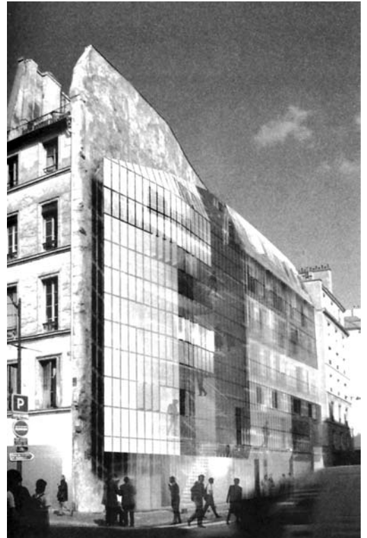
FIG. 12. Ámbitos de actuación. Zonas de expansión - franjas perimetrales permeables: Chartier y Corbasson. Rehabilitación de viviendas en Rue Saint Antoine, París. Una fachada metálica superpuesta define una franja de expansión de uso indefinido
