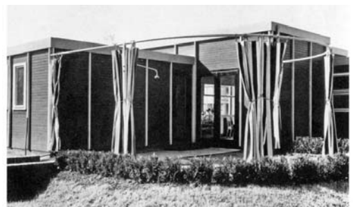
FIG. 3. Scharoun. Vivienda en la Exposición Deutsche Garten-und Gewerbeausstellung realizada de Liegnitz de 1927
