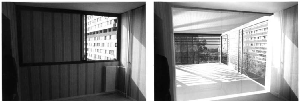
FIG. 11. Ámbitos de actuación: zonas de expansión - franjas perimetrales permeables: Lacaton y Vassal. A partir de la aplicación de la tecnología agrícola e industrial al campo de la arquitectura doméstica, Lacaton y Vassal proponen una arquitectura susceptible de operaciones de modificación y ampliación de límites con creación de franjas perimetrales
