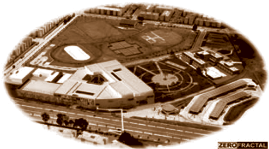
FIG. 16. Portal de la Calle 80 y centro comercial
