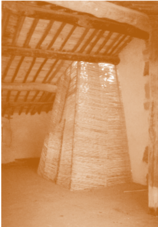
FIG. 15. Campana de chimenea en sobrado.
