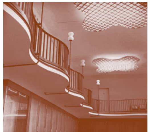
FIG. 5. Vista interior de la sala de ensayos con galería y detalle del entramado metálico con contorno ondulado de los lucernarios (imagen: Jolande Cornut-Custer)
