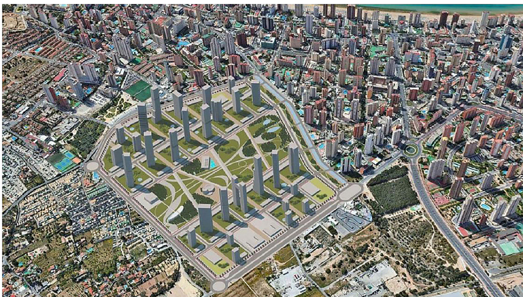
Fig. 10 / Imagen de la propuesta de ordenación del Plan Parcial “Ensanche de Levante” de Benidorm, un sector de suelo urbanizable por desarrollar, previsto en el PGMOU de 1990
