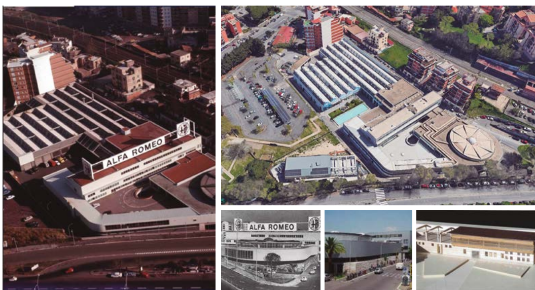
FIG. 7 / La antigua planta Alfa Romeo, hoy sede de la Facultad de Letras y Filosofía. Abajo a la derecha, la maqueta del edificio construido en la plaza interna
