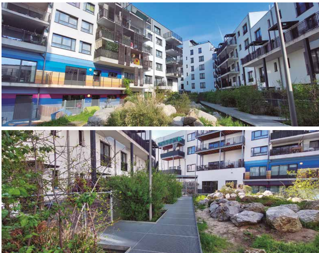
FIG. 20 / Relación entre la edificación (plantas bajas, patios privados, terrazas, portales) y el patio ajardinado comunitario
