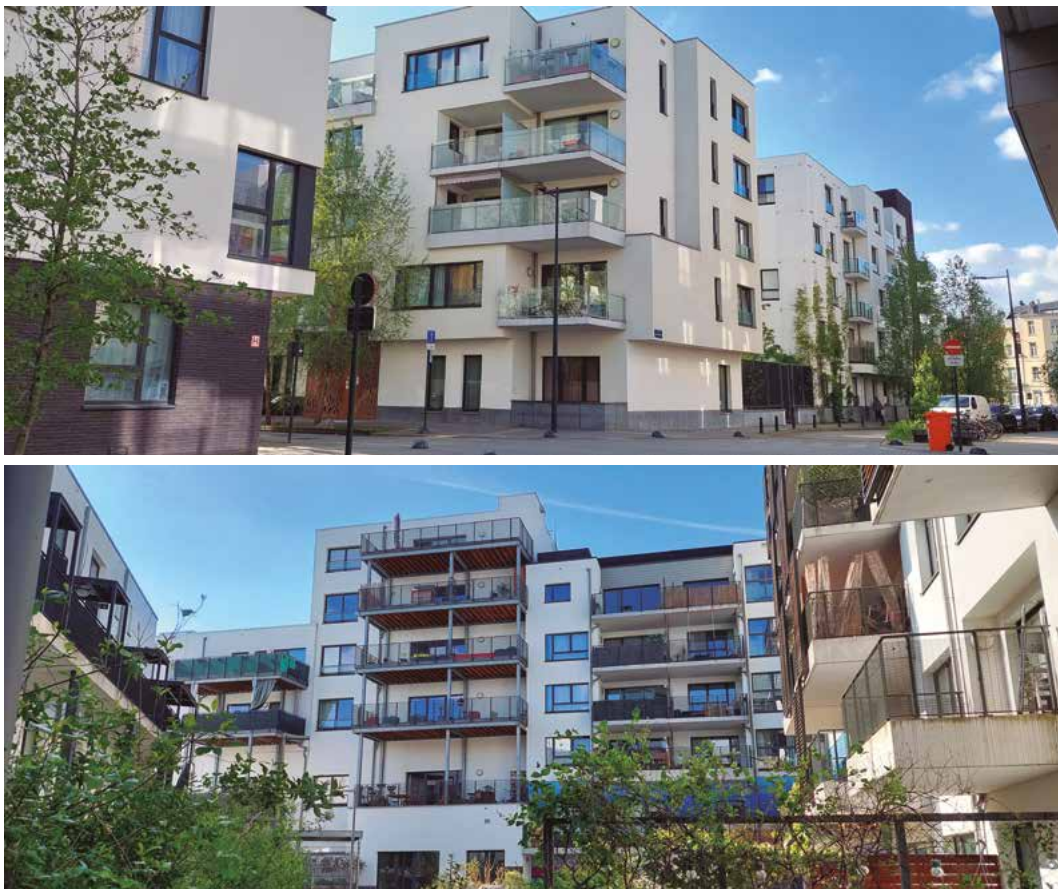
FIG. 19 / Arquitectura hacia el exterior de la manzana y hacia el interior. Espacios de transición y terrazas
