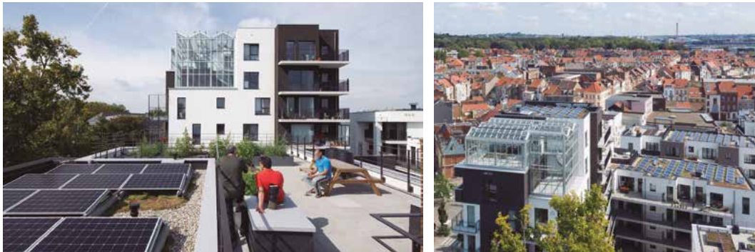
FIG. 22 / Vista de una zona común estancial en la cubierta y del invernadero experimental
