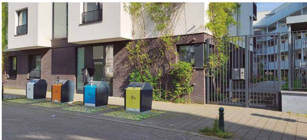
FIG. 16 / Contenedores subterráneos para la recogida selectiva de residuos
