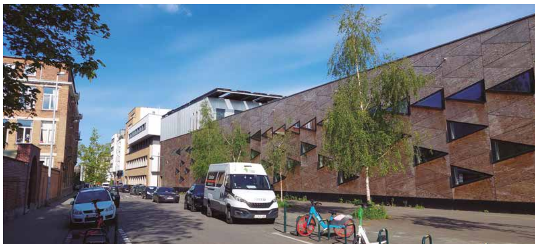
FIG. 3 / Exterior del edificio de Greenbizz desde la Rue du Molenbeek
