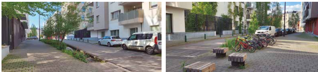
FIG. 9 / Detalles de la sección viaria: banda terraza drenante con vegetación, pavimento con juntas anchas y estrechas, banda de aparcamiento, mobiliario urbano
