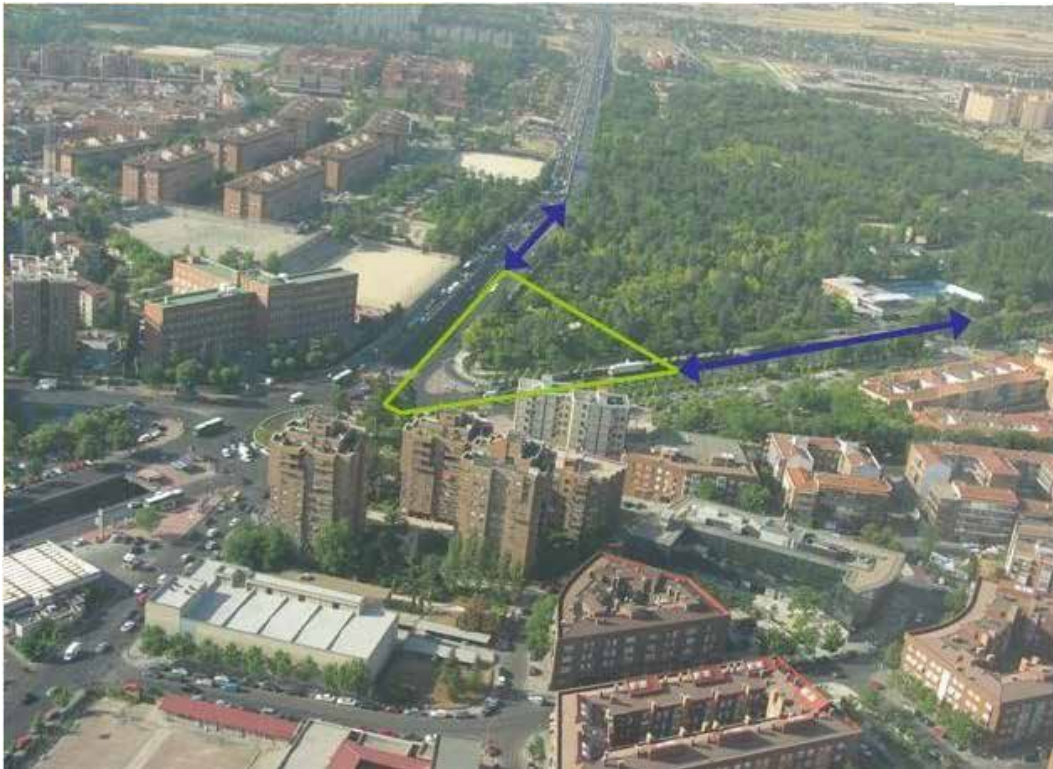
FIG. 2 / Situación previa a la construcción del Intercambiador, situado en el Parque Emperatriz Juana de Austria, entre la Avenida de Vía Lusitana y la Salida por la A-42 en Madrid
