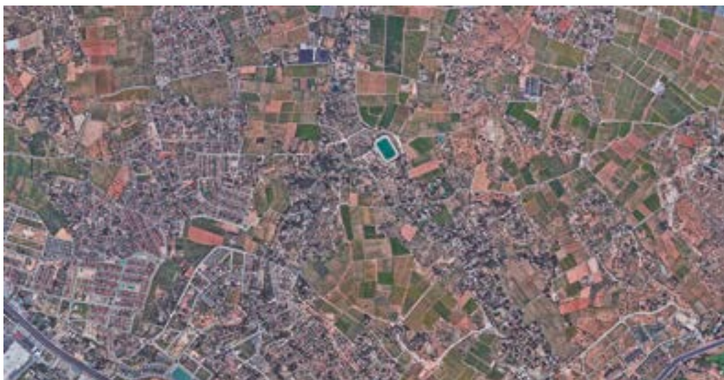
FIG. 4 / Ejemplo de asentamientos urbanos residenciales de baja densidad compartiendo 3 términos municipales valencianos (Bétera, S. Antonio de Benagéber y La Pobla de Vallbona, a escasos 15 km de Valencia) sin ninguna interrelación con los espacios resultantes de una huerta ahora fraccionada y discontinua
