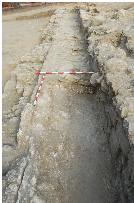
Figura 7. Refuerzo, de época romana, en la base de la muralla púnica (Proyecto Carteia, UAM, 2007).
