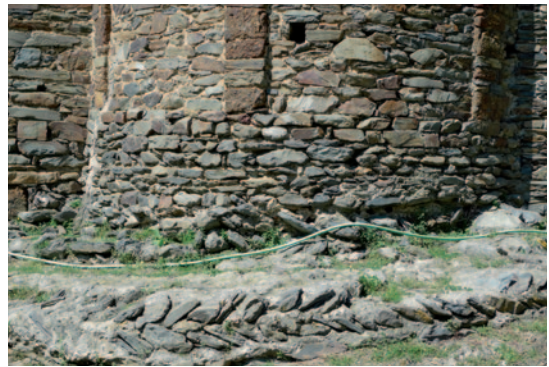
Figure 6. Apparent anti-seismic structures formed by assembled stones with spike-like disposition in the original foundations of the Sant Quirze de Colera Monastery. Figura 6. Posibles estructuras antisísmicas formadas por disposición en espiga de mampuesto de roca en los cimientos del Monasterio de Sant Quirze de Colera.
