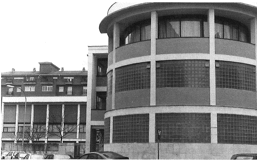
Figura 2. Centro de Salud de Rochapea. Vista parcial. 1997.
